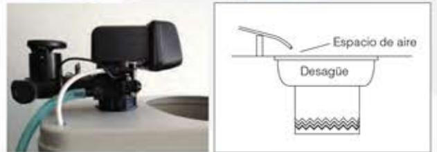
12. Placer également un tuyau à la sortie de débordement à l'évacuation (conduite d'évacuation), pour éviter une possible inondation en cas de mauvaise programmation, ou une fuite d'eau en cas de mauvais montage ou de panne de la vanne. Le niveau d'évacuation doit être situé au-dessous de la sortie de débordement.
