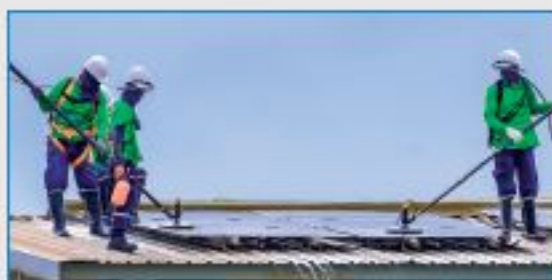
Nettoyage de panneaux solaires
