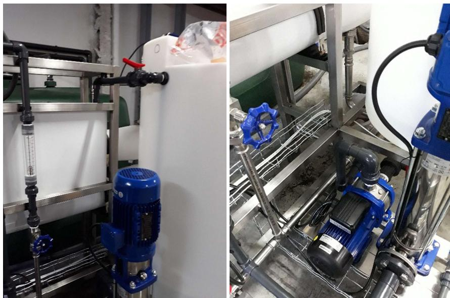
Imagen representativa conexiones skid de flushing en la misma estructura.
