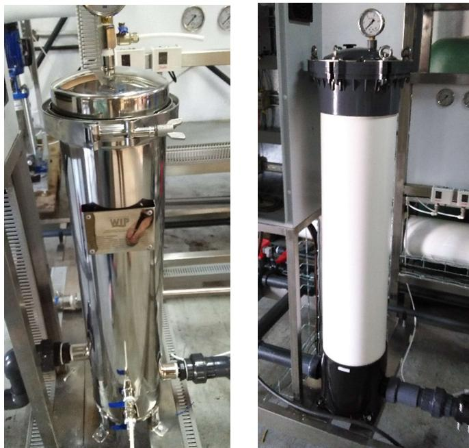
Image de filtre multi-cartouche en acier inoxydable et PVC respectivement.
