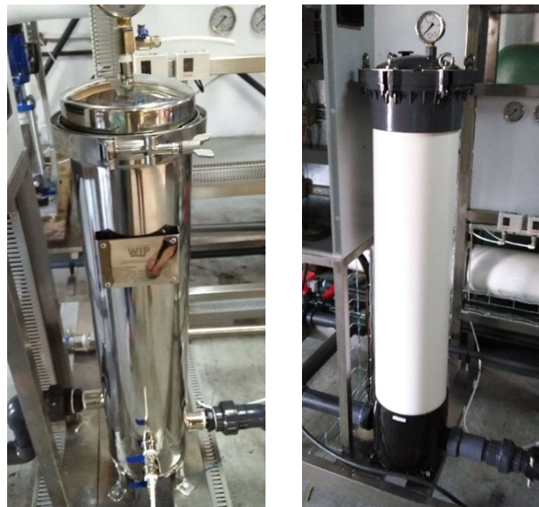
Imagen de filtro multicartucho en acero inoxidable y en PVC respectivamente. Opcionales
