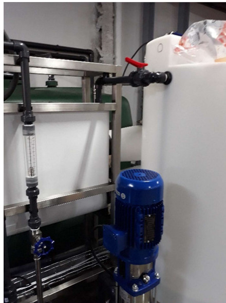
Imagen representativa conexiones skid de flushing en la misma estructura.
