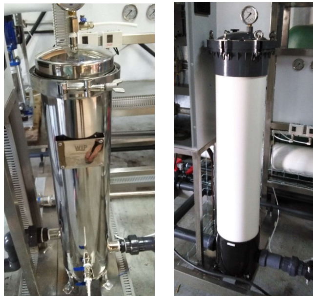
Image de filtre multi-cartouche en acier inoxydable et PVC respectivement. Optionnel.
